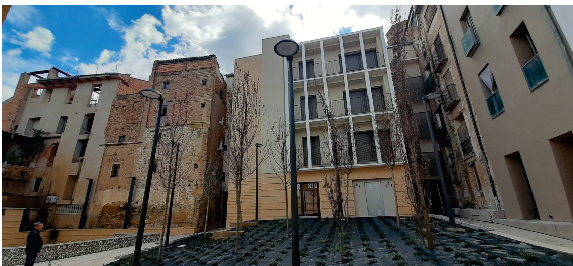
Vista de la plaza interior hacia los dos pasajes de unión con Plaza Vieja
