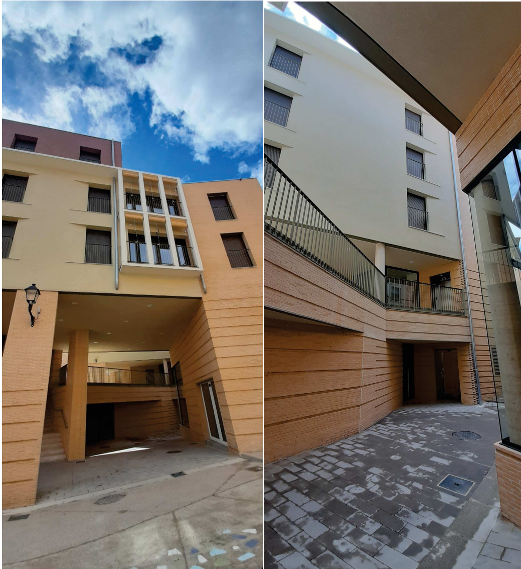
Vistas del ascensor desde zona intersección entre calles Pontarrón y San Antón
